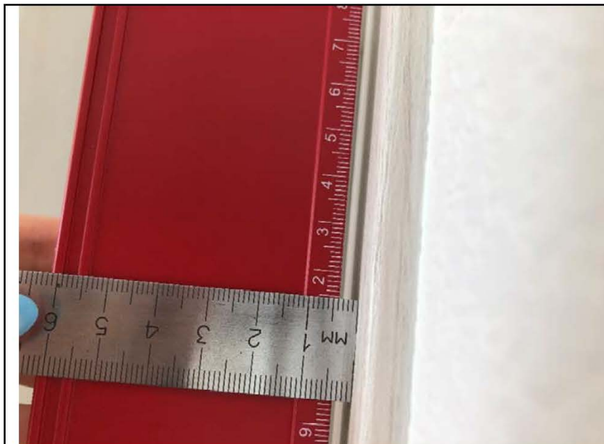
Фото №22. Измерение уровня наличника двери в спальне.
