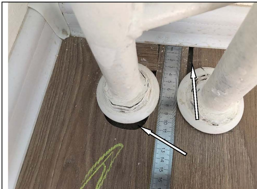
Фото №25. Дефект заделки отверстия для трубопровода отопления в напольном покрытии в спальне.
