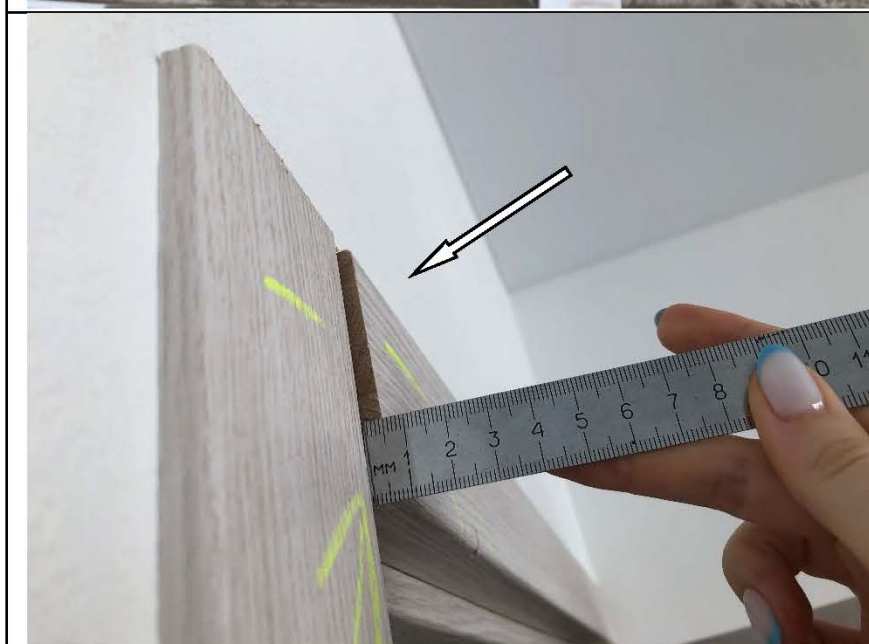
Фото №54. Дефект наличника дверного блока в детской.
