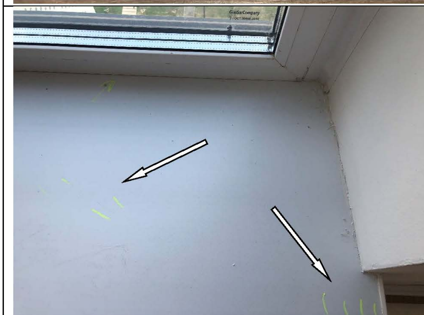
Фото №39. Дефект подоконной доски в детской комнате (загрязнения, царапины) .
