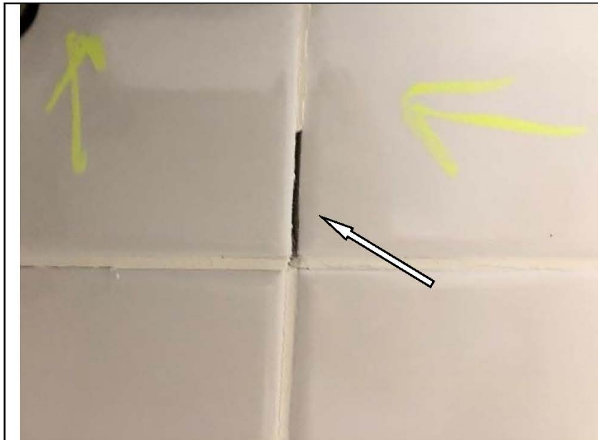
Фото №61. Дефект затирки настенной плитки в санузле.
