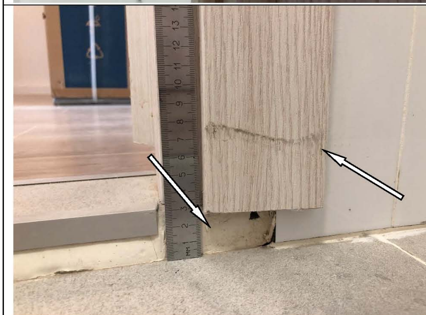
Фото №56. Дефект наличника дверного блока в ванной комнате (загрязнен). Дефект наличника дверного блока (отсутствует примыкание к поверхности пола).
