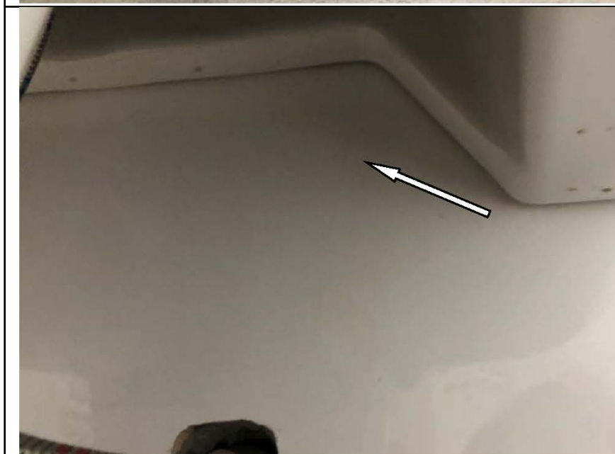
Фото №66. Трещина на настенной плитке в ванной комнате.
