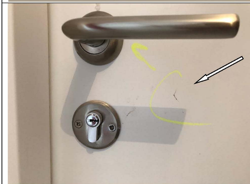
Фото №32. Дефект полотна двери входной двери (загрязнения, царапины).
