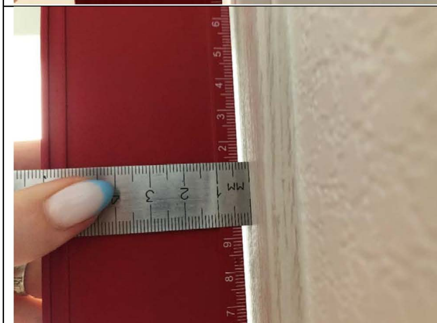
Фото №21. Измерение уровня наличника двери в ванной комнате.
