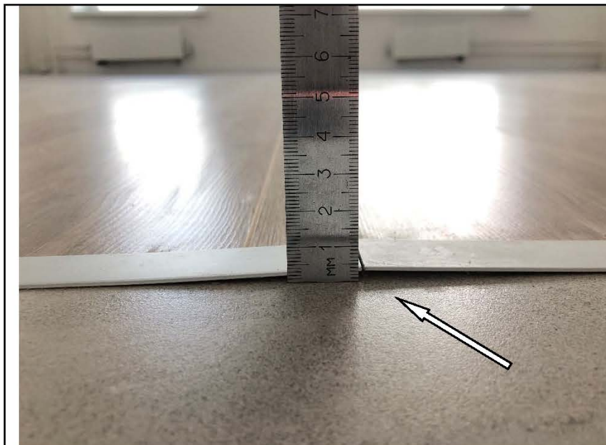
Фото №37. Дефект напольного металлического порожка в кухне-нише.
