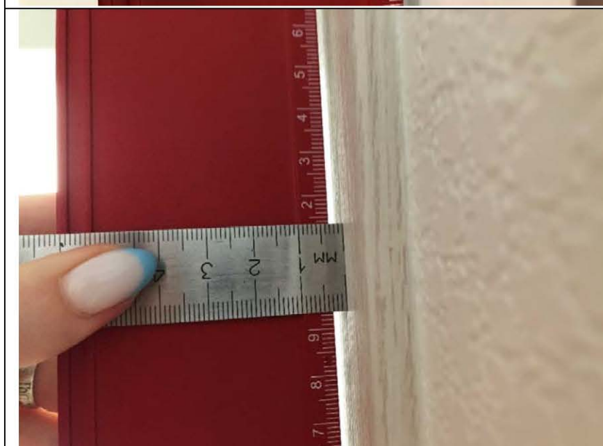
Фото №15. Измерение настенной плитки санузла в квартире.
