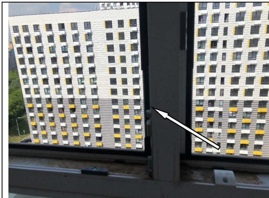
Фото №70. Отсутствует часть уплотняющей прокладки на оконном блоке ПВХ в общей комнате.
