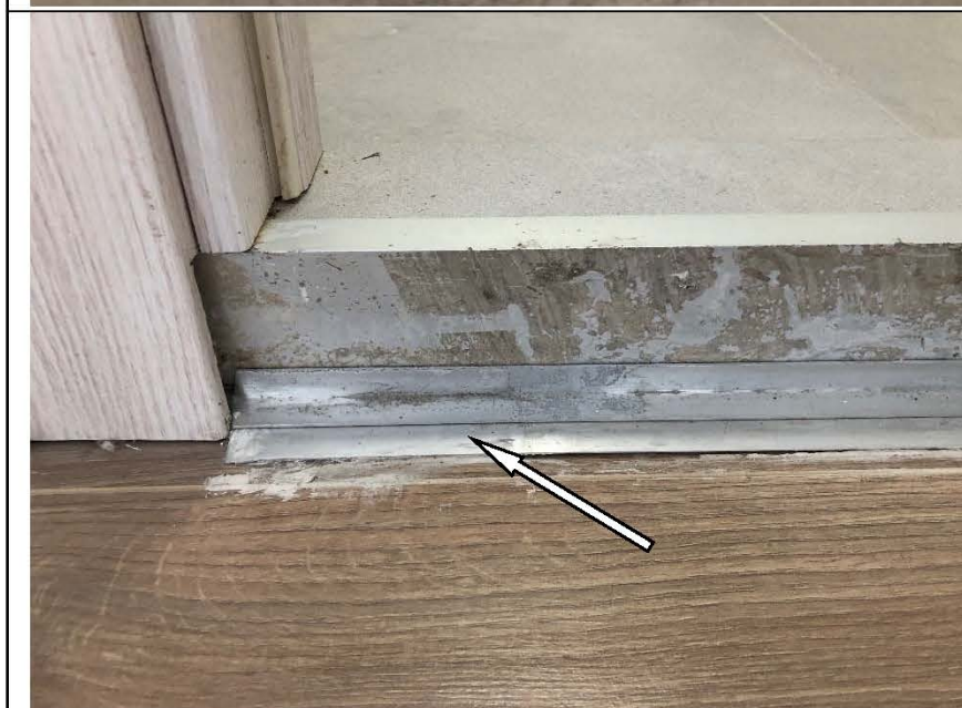
Фото №38. Дефект напольного металлического порожка в кухне-нише (механическое повреждение, загрязнение).
