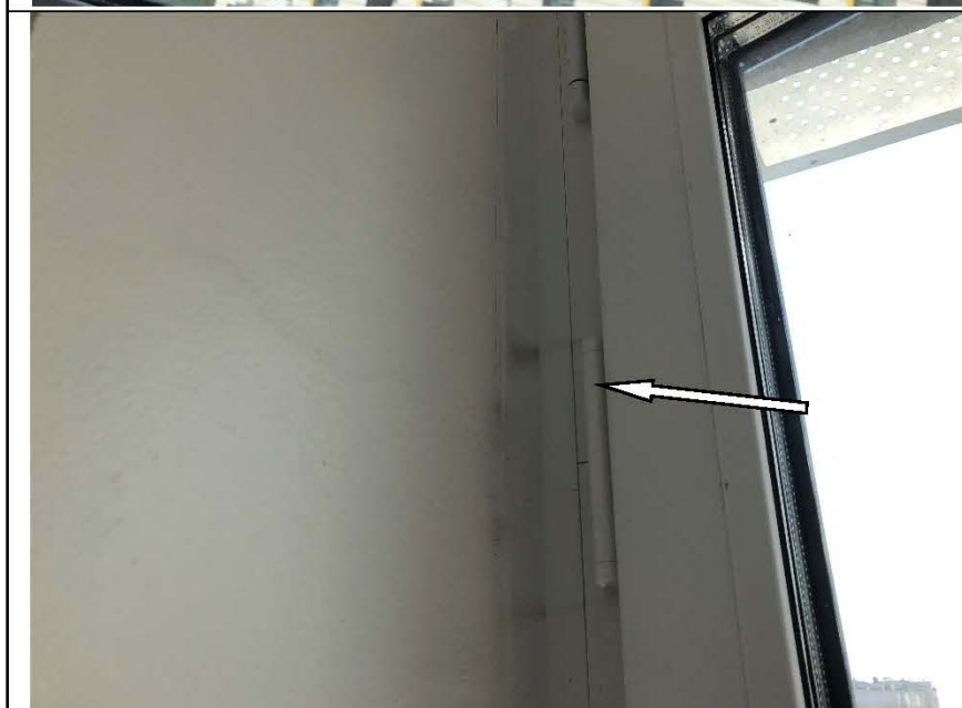
Фото №50. Следы инфильтрации воздуха оконного блока в спальне.
