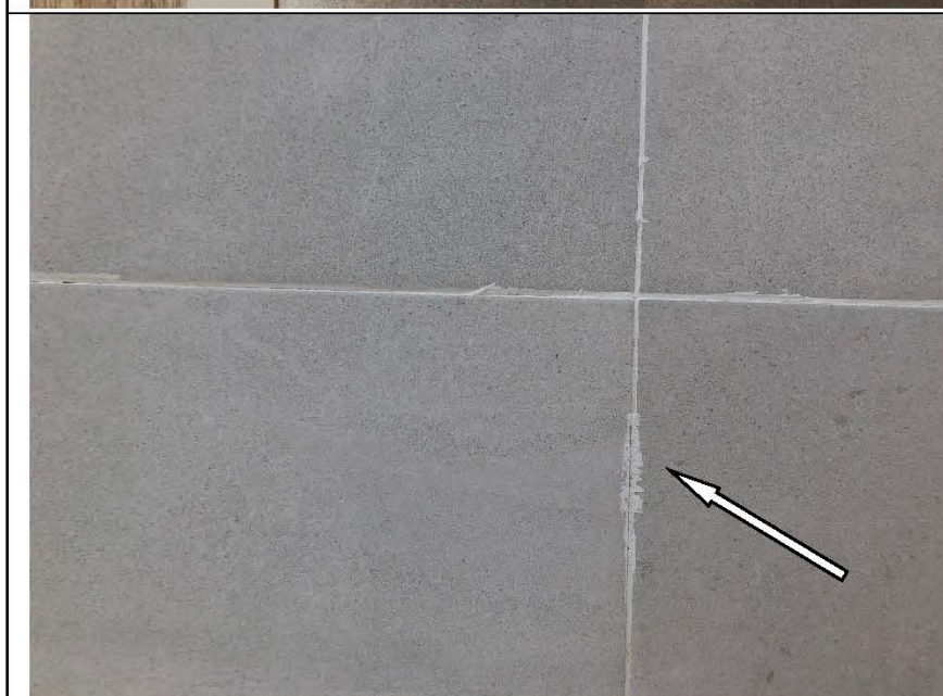
Фото №35. Дефект затирки напольной плитки в кухне- нише.
