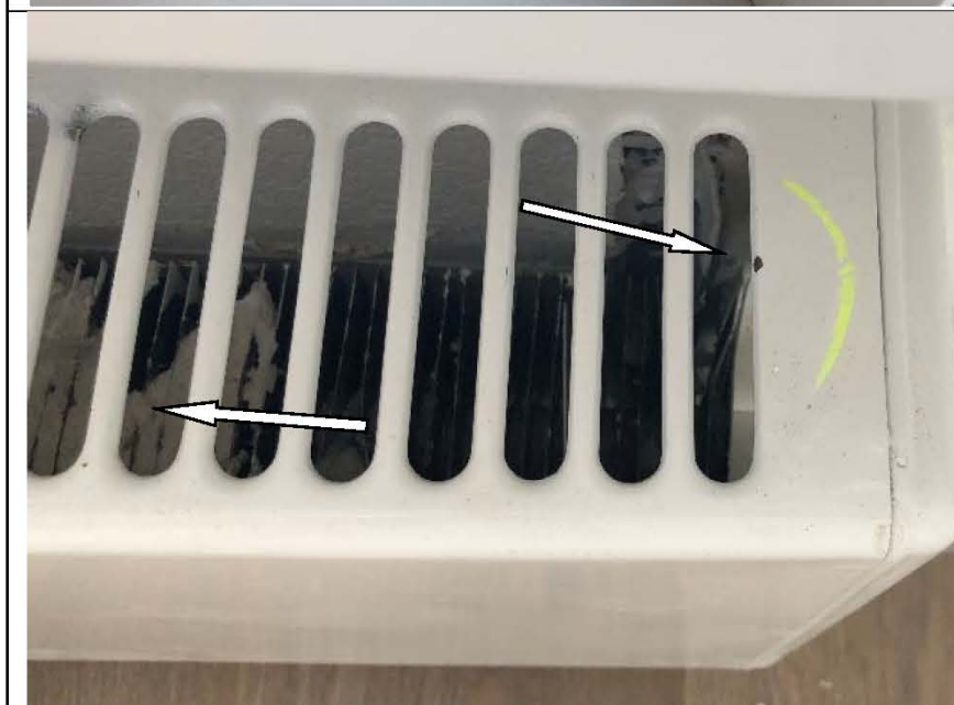
Фото №44. Дефект кожуха радиатора в общей комнате (сколы, загрязнения). Дефект радиатора (загрязнение).
