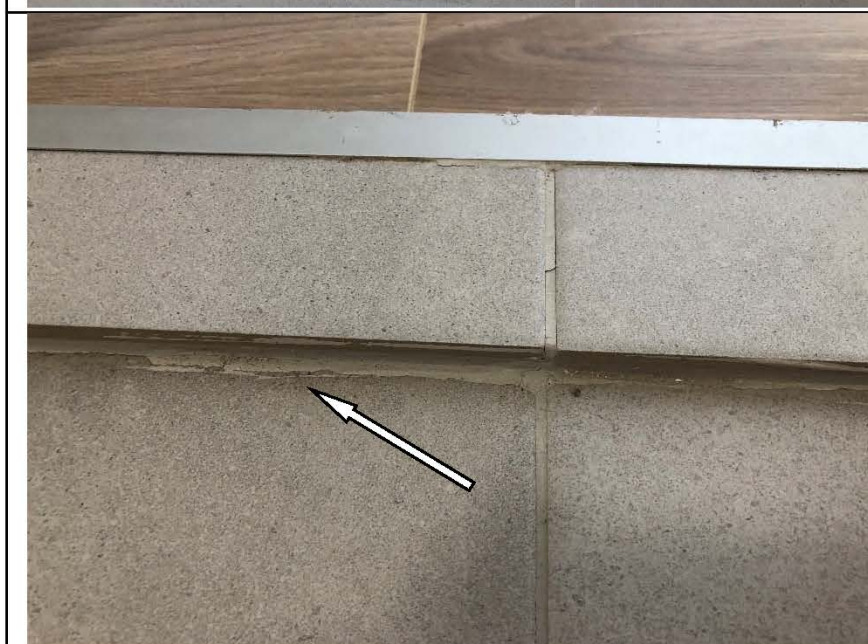
Фото №36. Дефект затирки напольной плитки в санузле.
