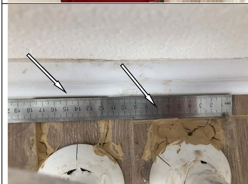
Фото №24. Дефект заделки отверстия для трубопровода отопления в напольном покрытии в детской.
