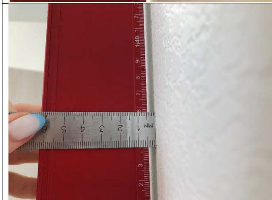
Фото №11. Измерение уровня стен спальни в квартире.
