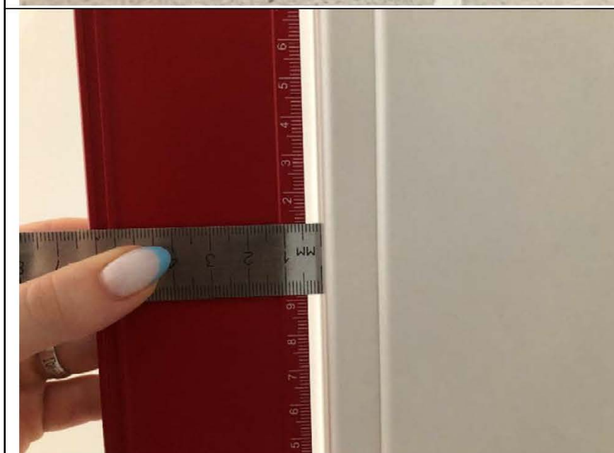
Фото №20. Измерение уровня наличника входной двери.
