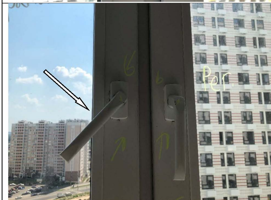
Фото №59. Фурнитура оконного блока ПВХ в спальне не отрегулирована.
