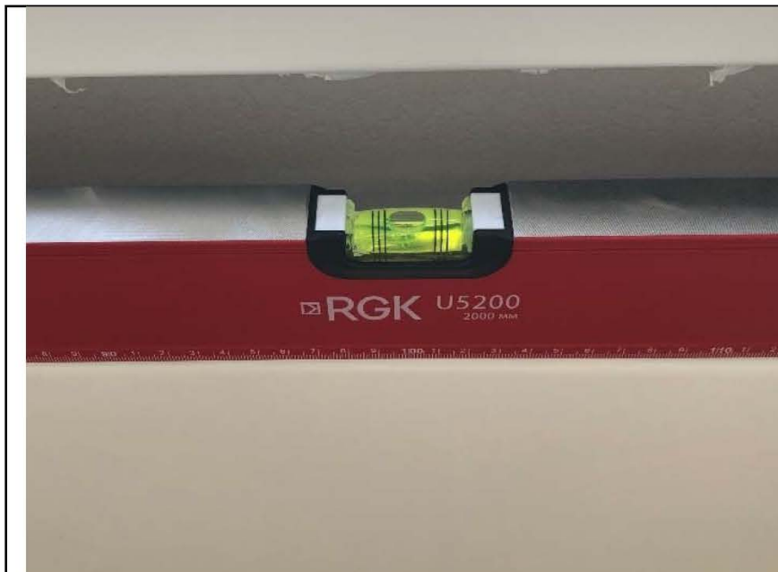
Фото №31. Неровно смонтированный отопительный прибор в детской.
