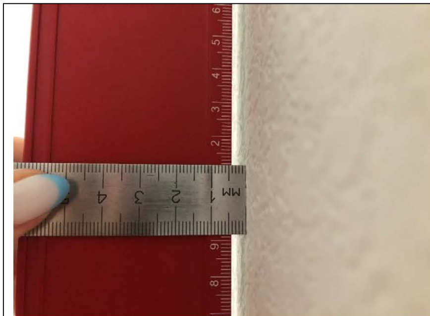
Фото №10. Измерение уровня стен коридора в квартире.
