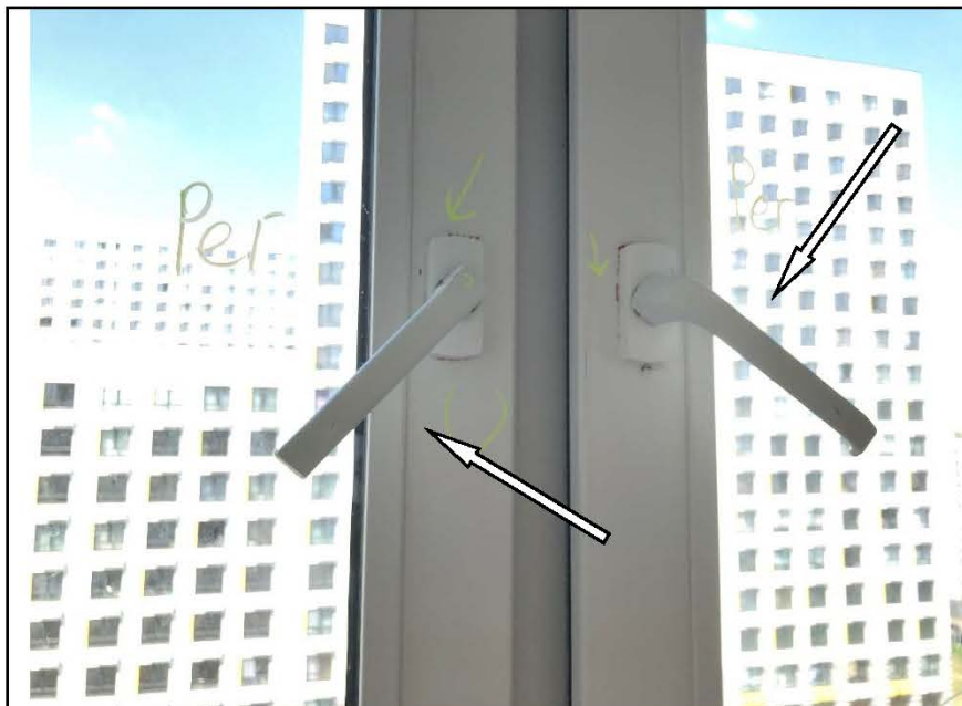
Фото №58. Фурнитура оконного блока ПВХ в детской не отрегулирована.
