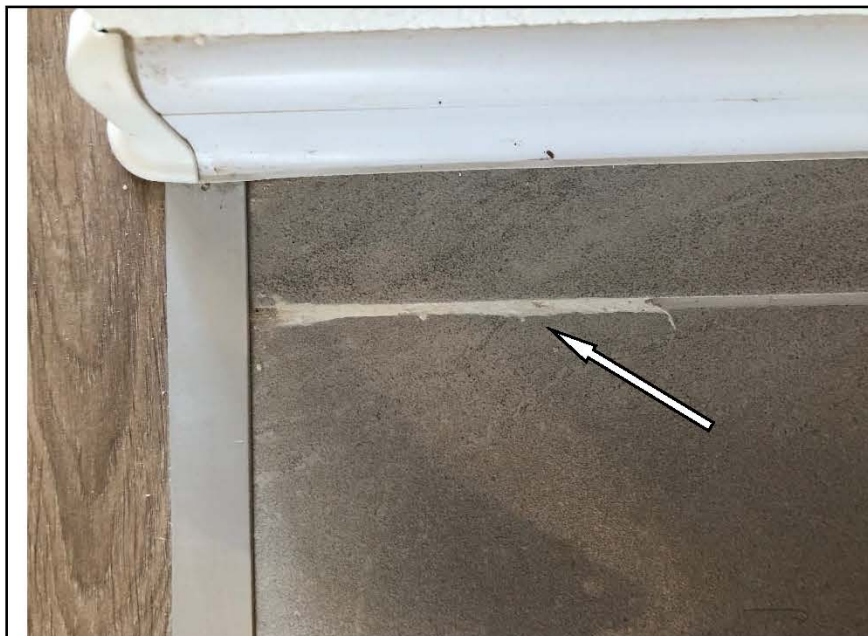
Фото №34. Дефект затирки напольной плитки в коридоре.
