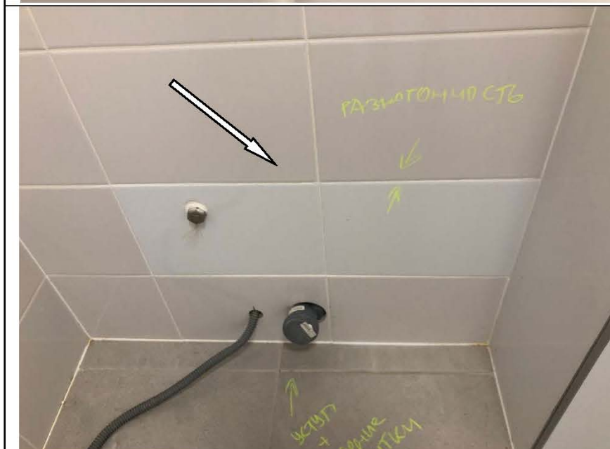
Фото №62. Разнотонность настенной плитки в санузле.
