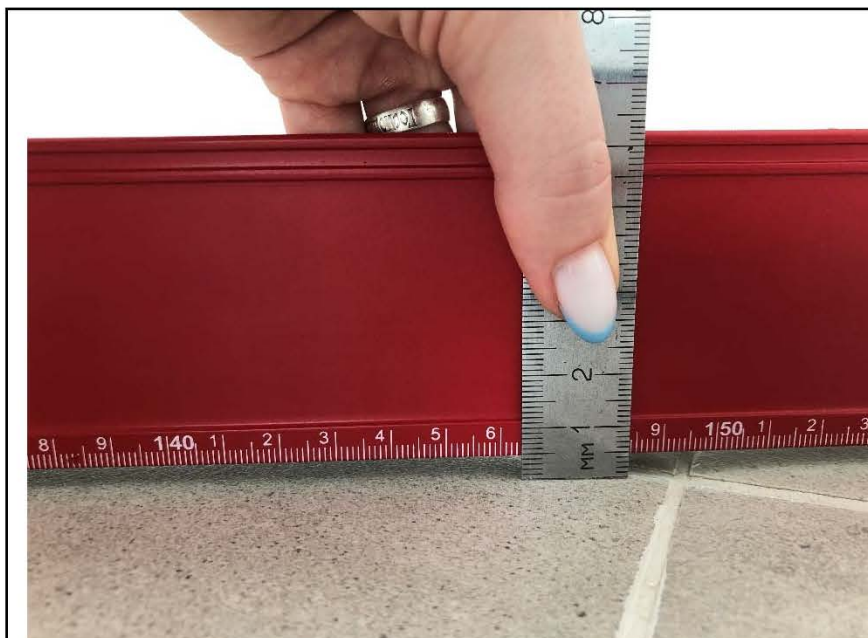
Фото №19. Измерение напольного покрытия ванной комнаты в квартире.
