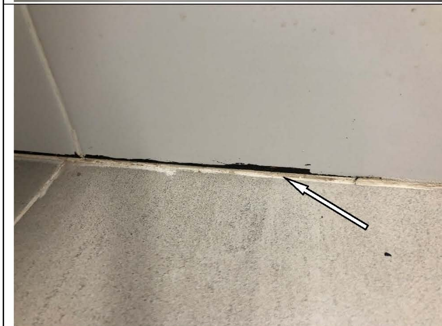
Фото №65. Загрязнение настенной плитки в ванной комнате.
