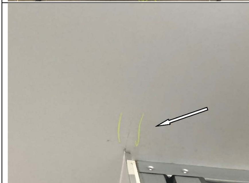
Фото №63. Натяжной потолок в санузле загрязнен.
